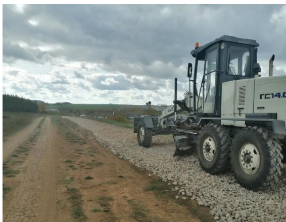
Ощебенение дороги по ул. Полевая с. Бураново
