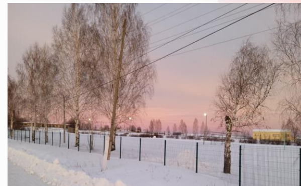
Ограждение и освещение терри- тории спортивного стадиона в д. Иваново-Самарское
