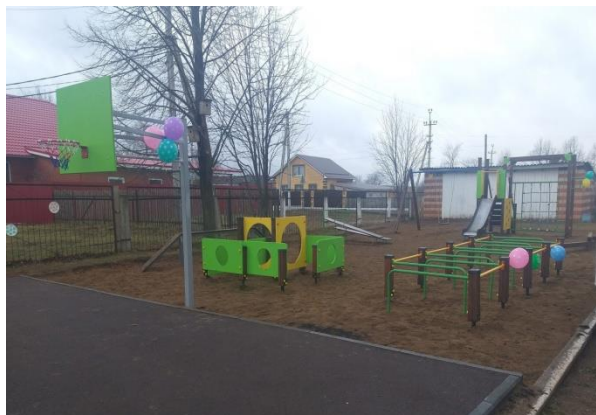
Устройство спортивной площадки в детском саду с. Ильинское
