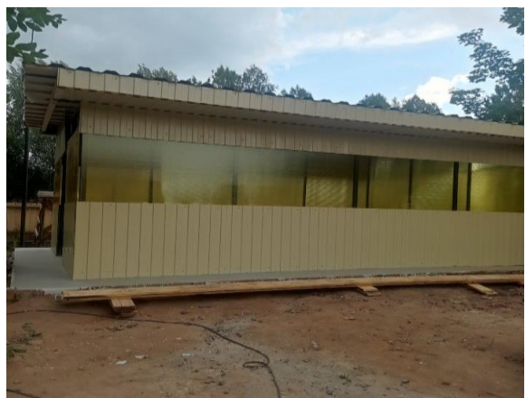
Устройство беседки в д. Кечур
