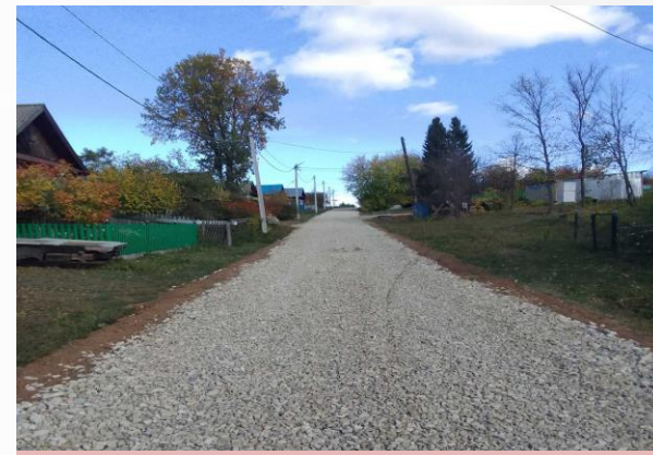
Щебеночная дорога по ул. Центральная, д. Усьян
